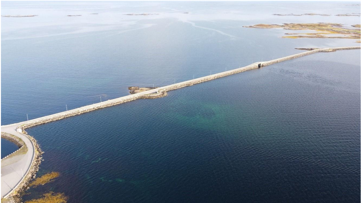
Figur 1—2. Oversiktsbilde Finnøybrua. Hentet fra Oppdragsbeskrivelse forprosjekt/planprosjekt Finnøybrua. Foto: Erling Mørch.
