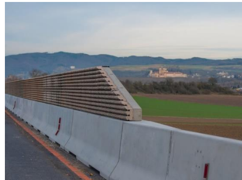
Figur 7: Eksempel på modulbasert støyskjerm med betongblokker som fundament. Kilde: Garda Rebloc Støyskjerm
