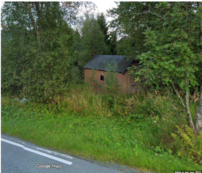
Figur 7-1: SEFRAK-registrert bygning ved Støverstein som må rivast. Kjelde: Google maps, 2025.
