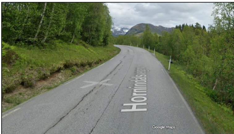
Figur 4-1: Dagens fv.60 ved «Støversteinsvingane», sett mot aust. Kjelde: Google maps, juni 2025.
