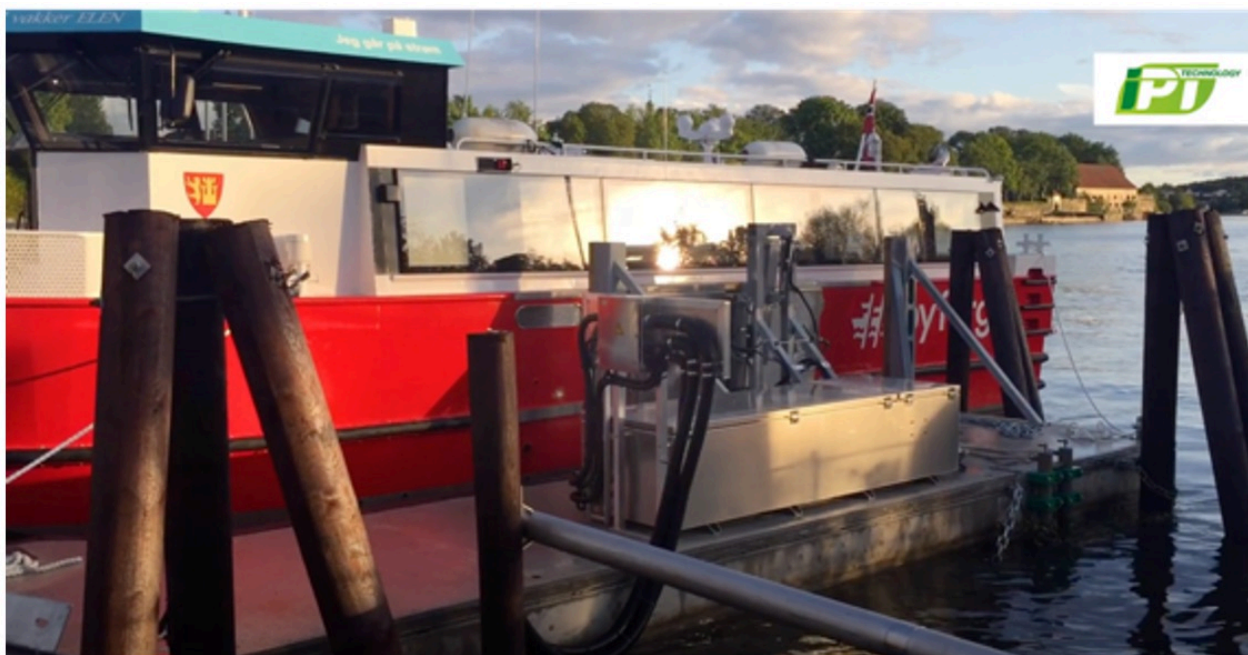
Figur 3-9: Induktiv ladning av mindre passasjerbåt –foto av ladesystem, /4/
