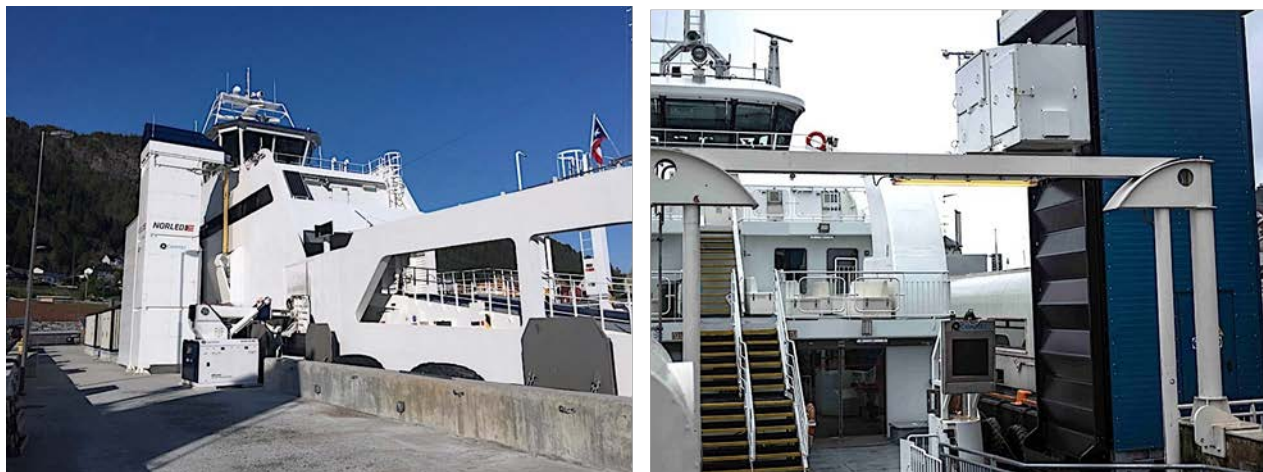
Figur 4-8: Eksempel på ladetårn med ladeplugg (venstre) og automatisk ladekobling(høyre). Ref.: https://www.cavotec.com/en/your-applications/ports-maritime/automated-mooring/electric-vessels
