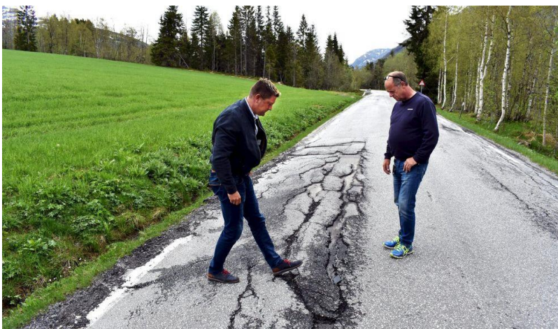
Figur 5 Vegen har tidvis vært svært dårlig Foto: Terje Engås, Sunnmørsposten mai 2017
