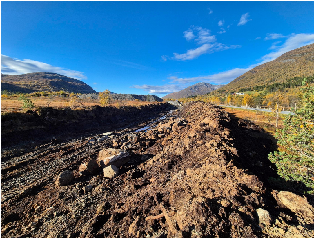
Figur 1: Utgraving for høyspentekabel, ca. profil 12.600.
