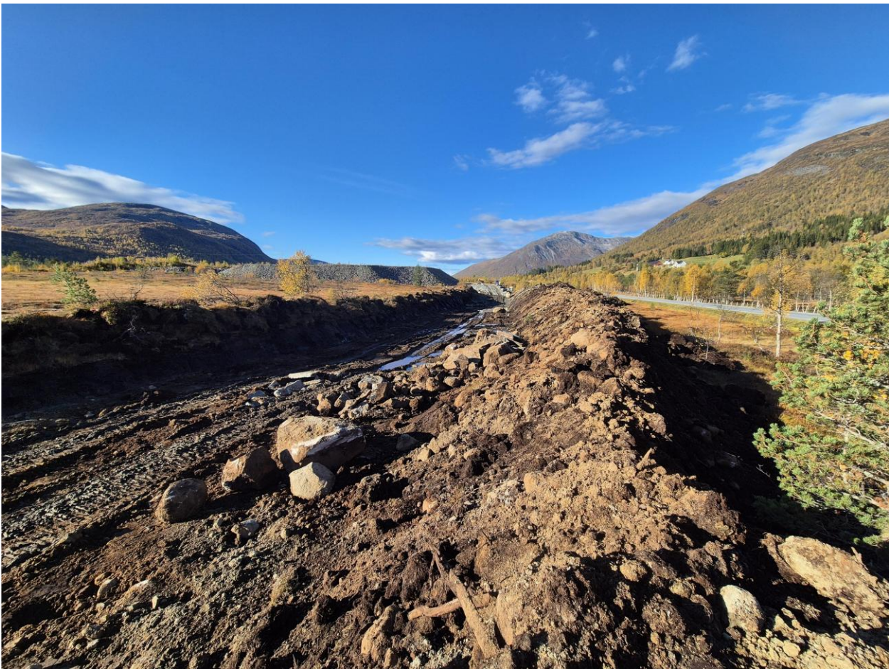
Figur 3-7: Grøft for ny jordkabel fra Røyhus kraftverk over Liamyrane, øst for Hjellhammaren, som vises som steinfylling på bildet.
