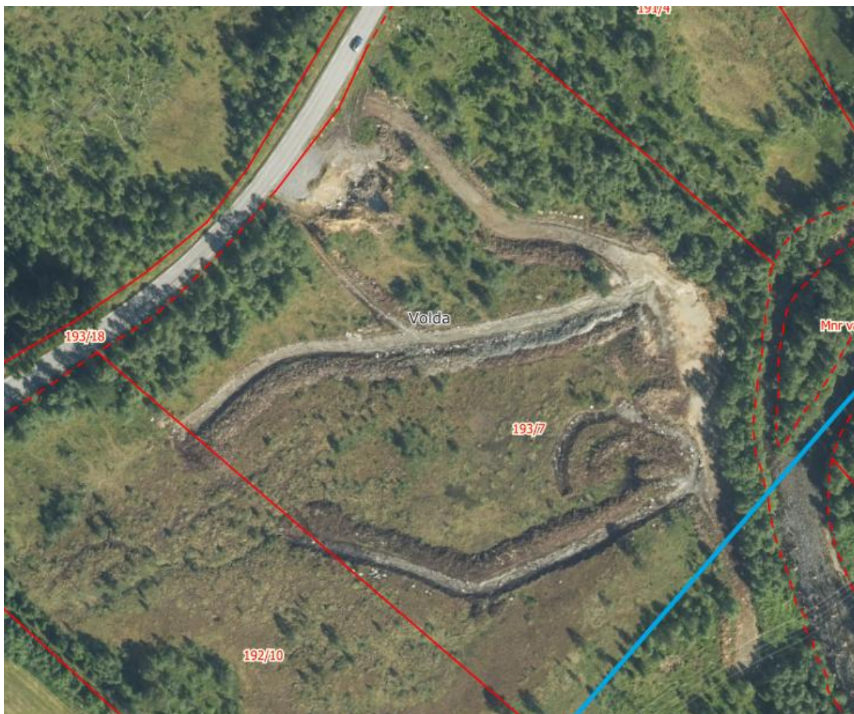
Figur 3-10: Grøfting for nydyrking i myr i område hvor det er planlagt massedeponi
